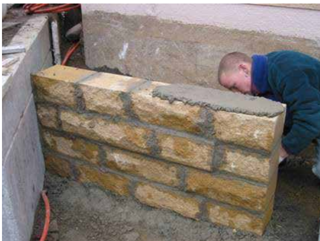
Bild 42 Aufbringen Mörtel für Abdeckplatte
