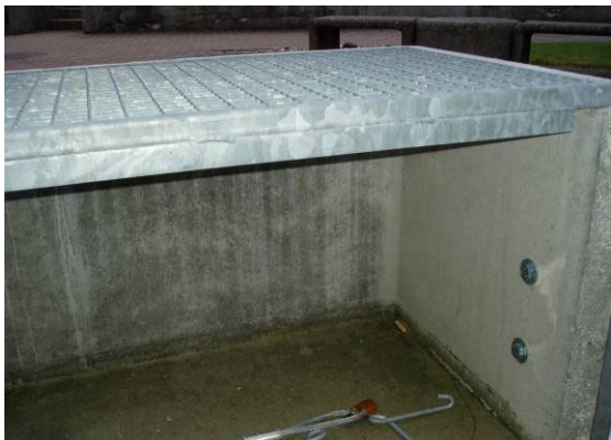
Bild 39: Verstärkte Gitterrostkante gegen die Hauswand
