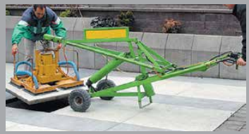
PRESTO APPAREIL DE POSE POUR DALLES
