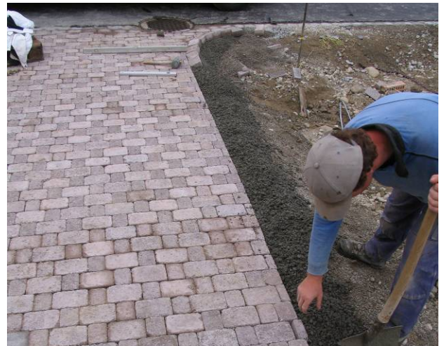
Bild 43: Erstellen des Randabschlusses
