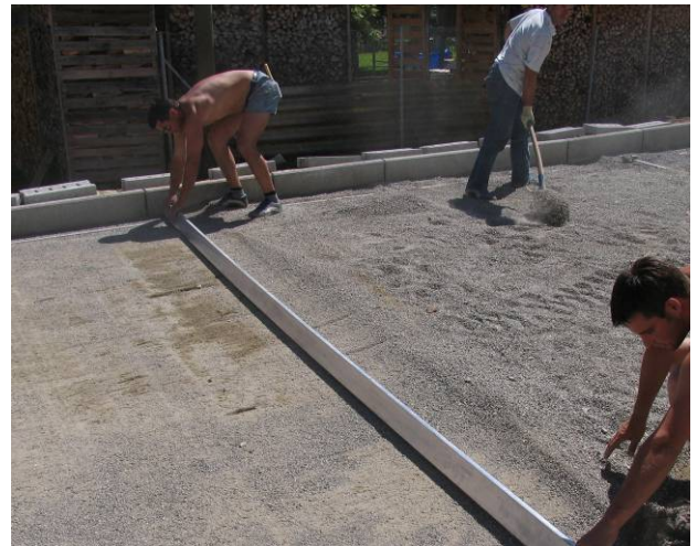
Bild 33: Abziehen der Bettungsschicht
