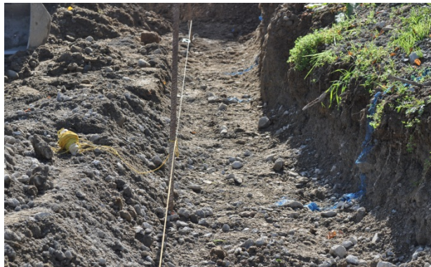
Bild 19: Aushub auf Frosttiefe
