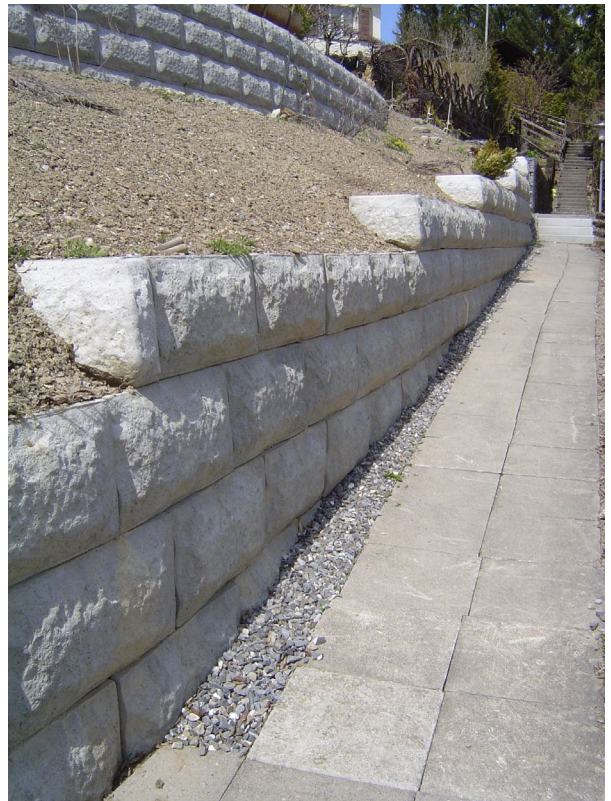
Bild 47: seitlicher Abschluss der Abtreppungen mit Ecksteinen
