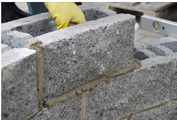
Bild 57: Versetzen von Radiussteinen
