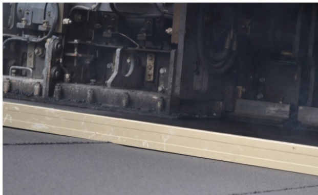
Bild 23: Kontrolle der Ebenheit
