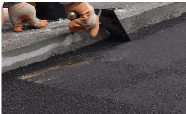
Bild 24: Kontrolle der Ränder
