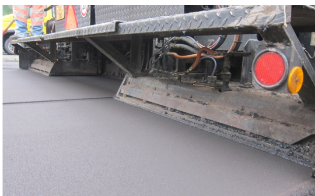
Bild 15: Rüttelbohle darf das Material nur anziehen
