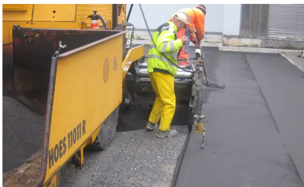
Bild 16: Nahtflanken sind abzukanten
