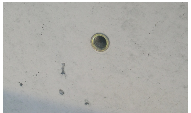
Bild 20: Werkseitig eingebaute Versetzhülsen
