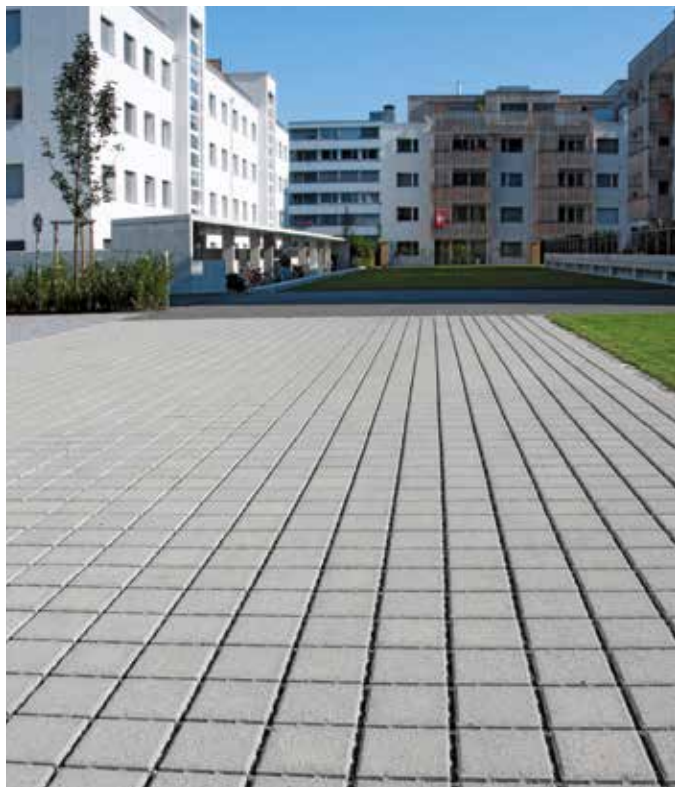
Parkfläche mit SPLITT Ökosteine
