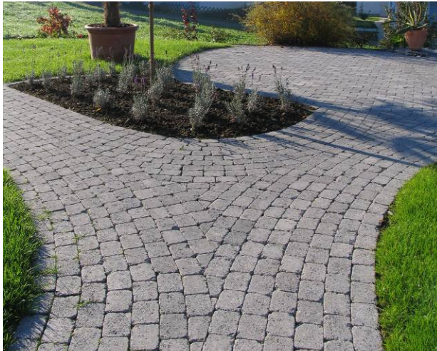
Bild 41: Pflasterfläche mit Passsteinen
