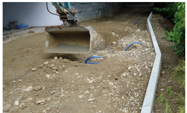
Bild 34: Lagenweises Einbringen von geeigneten Hinterfüllmaterial
