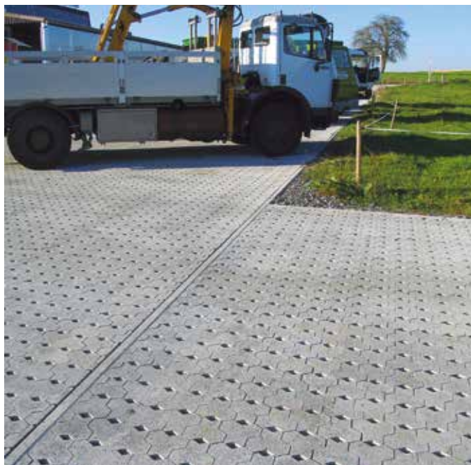
Parkfläche mit SIX SILENTA Ökosteine (Splittfugen)
