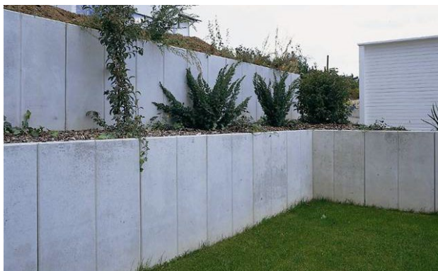
Bild 1: COMOFORTE® Winkelplatten als Böschungssicherung
