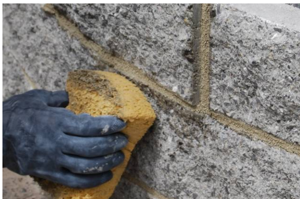
Bild 48: Aufräumen der Fugenfüllung und reinigen der Bausteine
