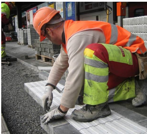
Bild 36: Verlegen der CARENA® Sicherheitsliniensteine H = 8 cm
