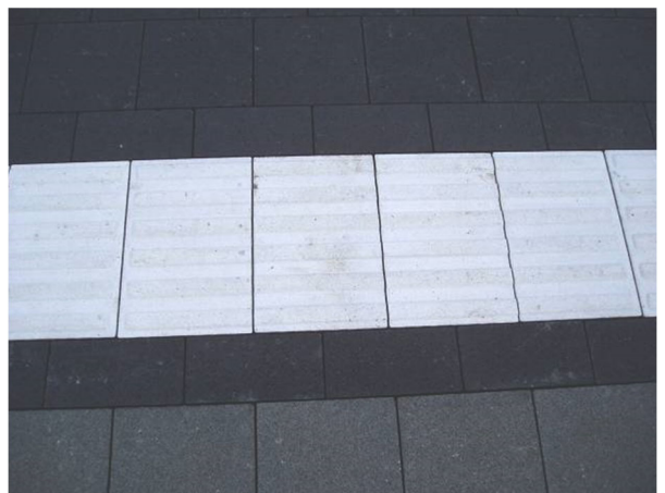
Bild 25: Optimale Fugenbreite
