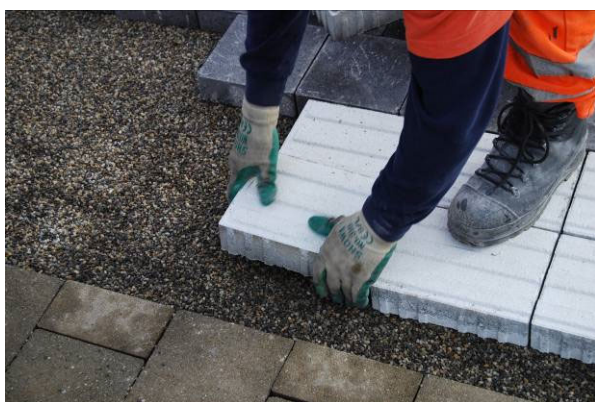
Bild 27: Verlegen von CARENA® Sicherheitsliniensteine H = 6 cm
