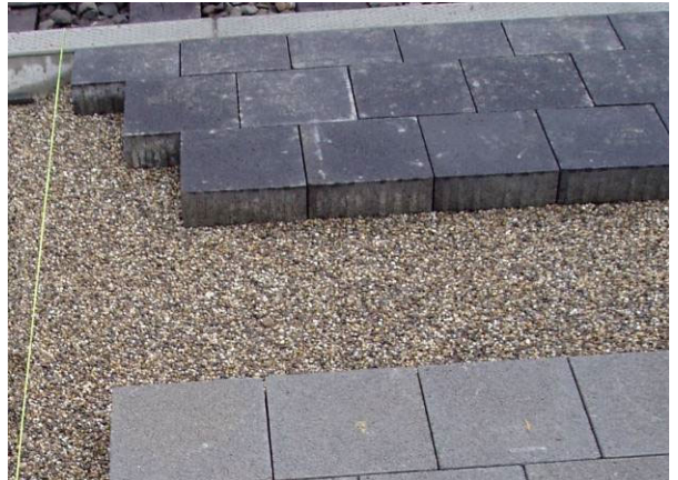
Bild 24: Eingebaute Bettungsschicht
