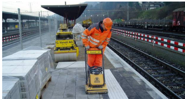
Bild 28: Einsatz eines Flachrüttlers
