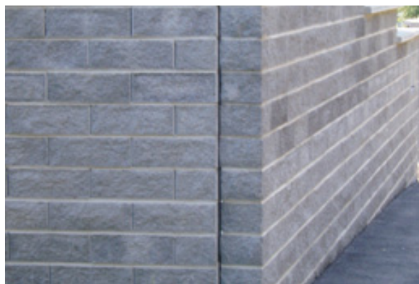
Bild 56: Vertikale Dilatationsfuge bei einer Eckausbildung
