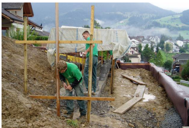
Bild 34: Setzen einer Richtschnur
