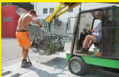
Maschinelles Verlegen
