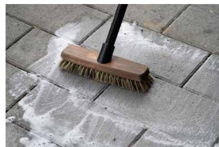
Application du produit de nettoyage
