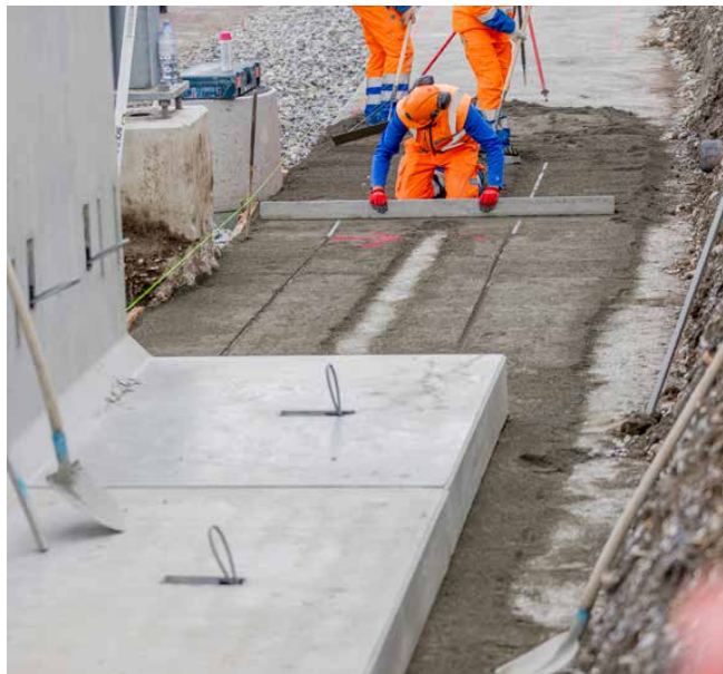
Pose des éléments sur semelle filante
