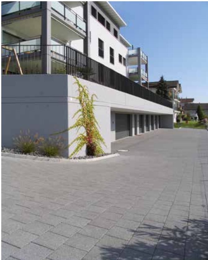
Versickerung durch Sickerstein
