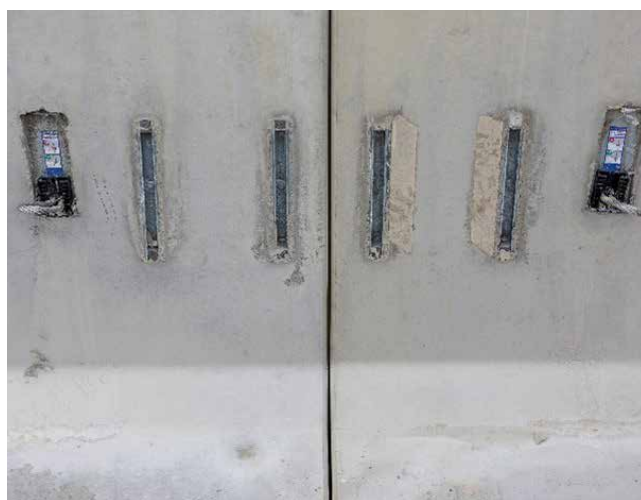
Rails Halfen comme système d'assemblage
