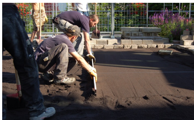
Bild 18: Mischgut abziehen
