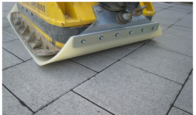
Bild 29: Abrütteln der Pflasterdecke
