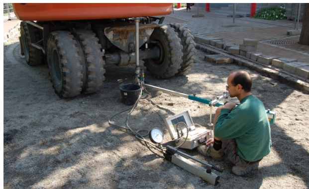
Bild 13: Kontrolle der Tragfähigkeit mit Me-Messungen
