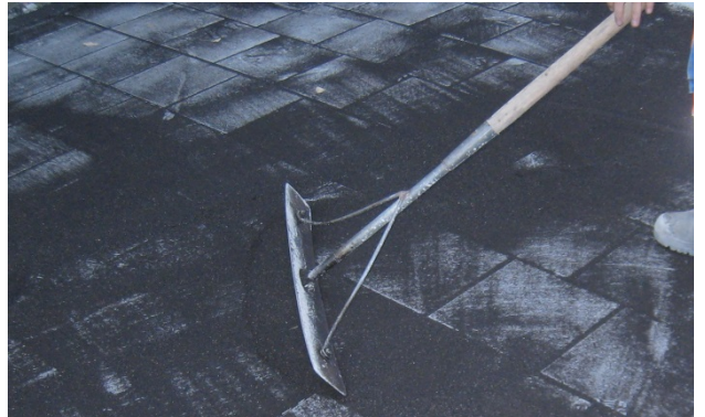
Bild 28: Einbringen des Fugenmaterials von Hand
