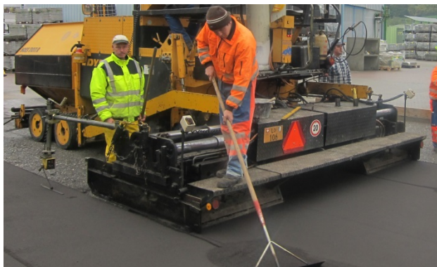
Bild 14: Einbau mit Asphaltfertiger
