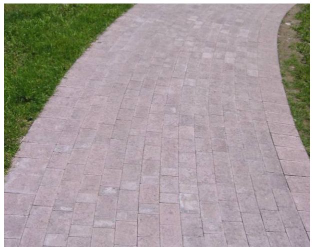
Bild 3: TEGULA® Pflastersteine porphyr, vollkantig
