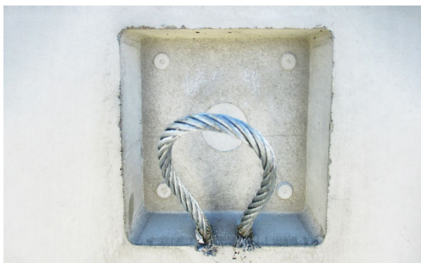
Bild 24: Werkseitig eingebaute Versetzschaufen
