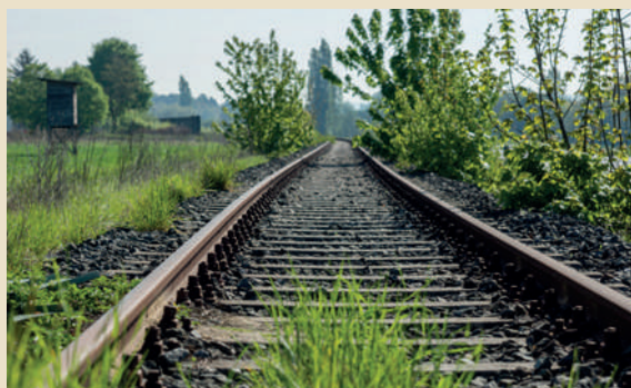
Bahngleis mit Bewuchs
