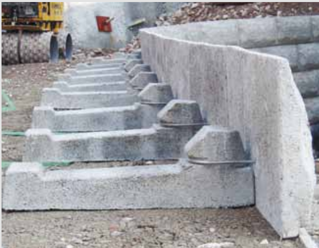
Frontplatten mit Erdanker
