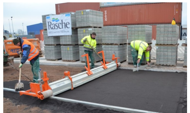
Bild 19: Mischgut abziehen
