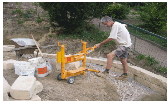
Bild 35: Arbeiten mit Steinspalter
