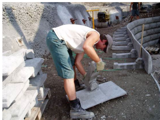
Bild 15: Frontplatte mit Anker verbinden
