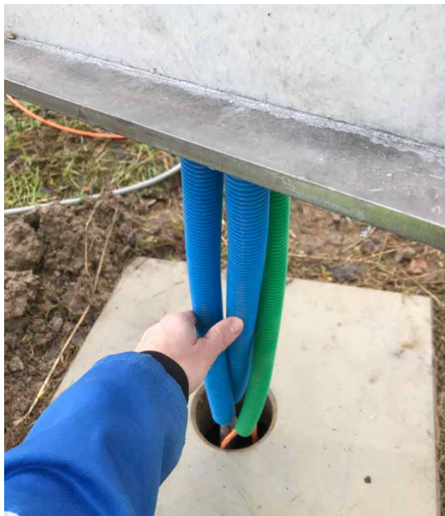
Introduction des tubes de protection des câbles
