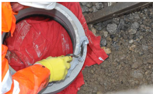
Bild 9: Auftragen der Klebmasse auf den Schaft
