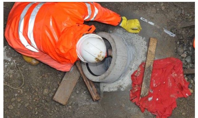
Bild 12: Innenkante von Hand modellieren und Reste entfernen
