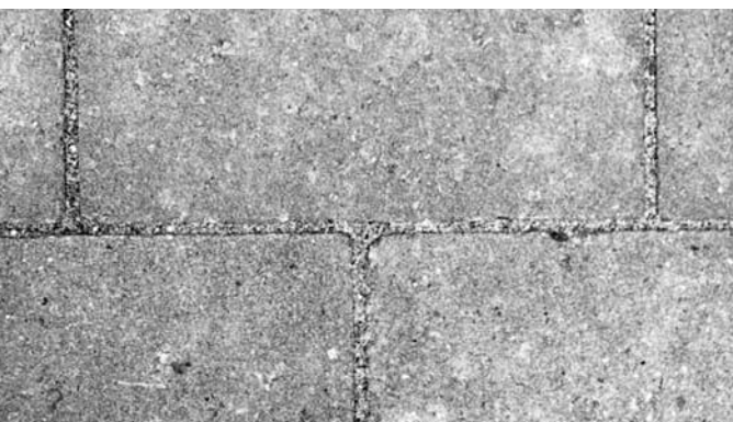
Wirksame Pflasterdecke durch funktionsfähige Fugen
