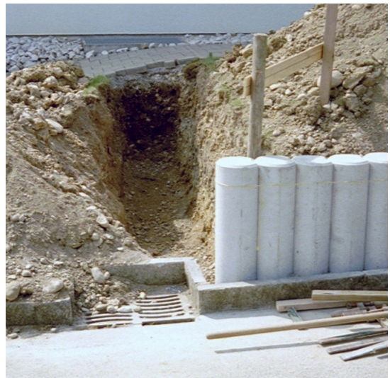
Bild 8: Aushub für Streifenfundament
