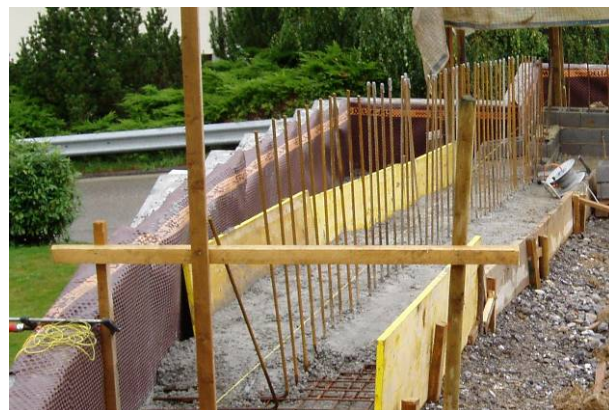
Bild 35: Fundament mit Anschlussbewehrung
