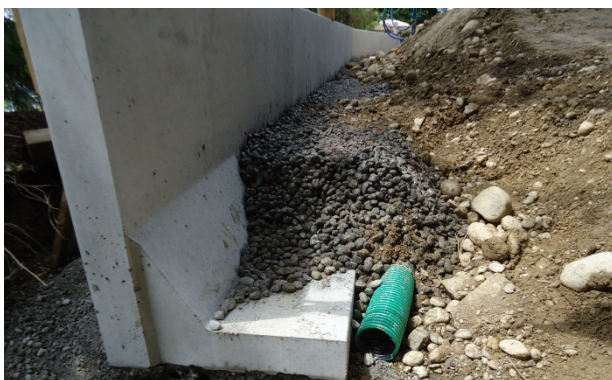
Bild 24: Einbau einer Sickerleitung
