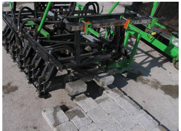
Bild 39: Maschinelle Verlegung mit OPTIMAS Verlegemaschine
