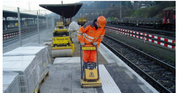
Bild 28: Einsatz eines Flachrüttlers
