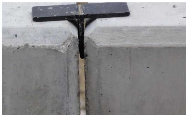
Bild 32: Optimale Fugen nach der Versetzung
