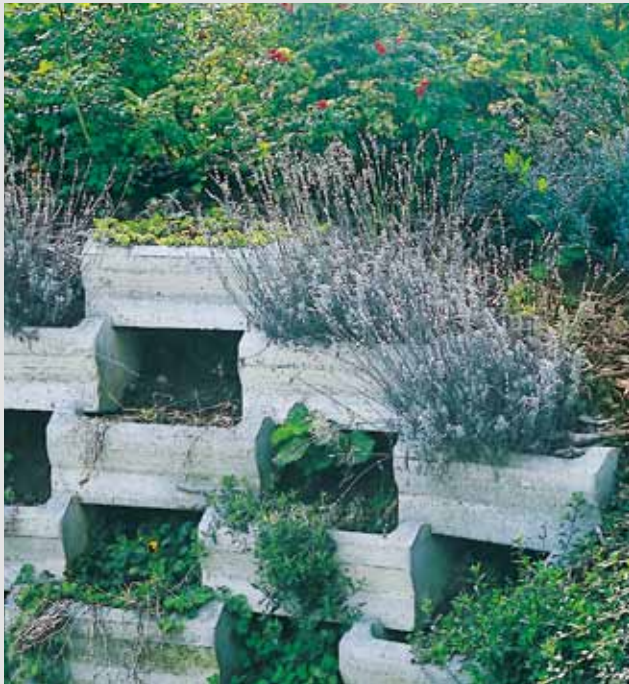
Böschungselemente
