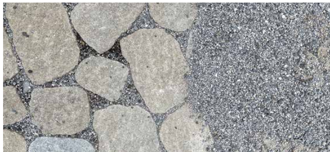
Remplissage des joints
