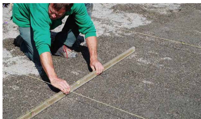
Réglage du lit de pose
