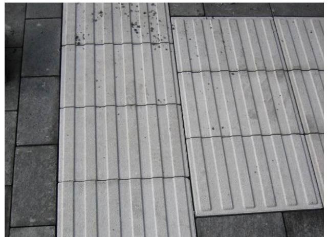
Bild 34: Optimale Fugen bei Steinen H = 8 cm
