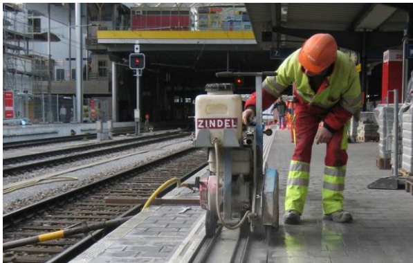
Bild 31: Einsatz einer kleinen Belagsfräse
