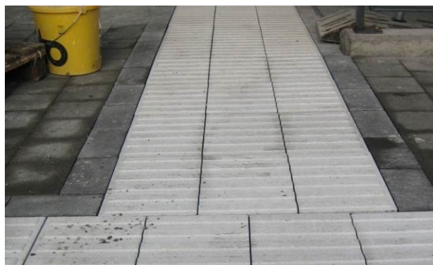
Bild 18: Anschluss Aufmerksamkeitsfelder an Sicherheitslinie
