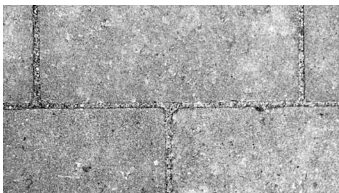
Wirksame Pflasterdecke durch funktionsfähige Fugen
