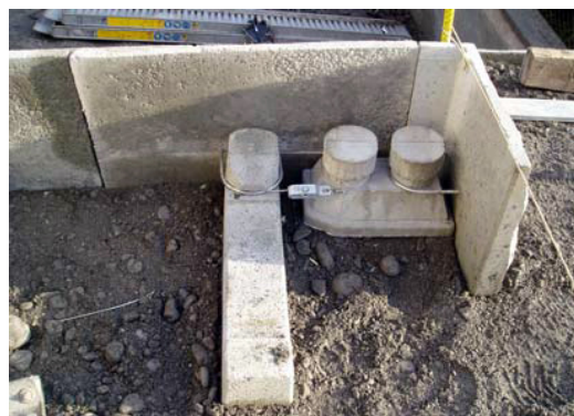
Bild 26a: Eckspanner parallel zum kleineren Schenkel montieren
