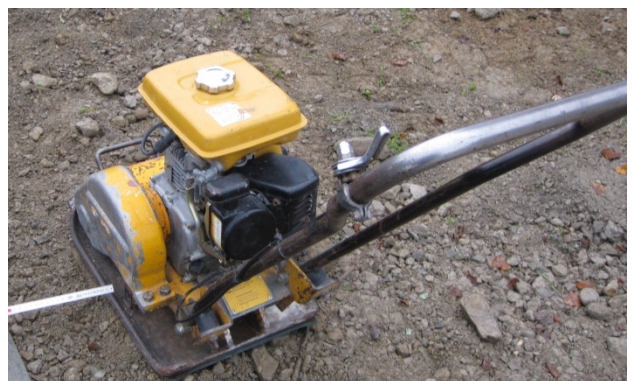
Bild 42: Verdichten nur mit sehr leichten Verdichtungsgeräten
