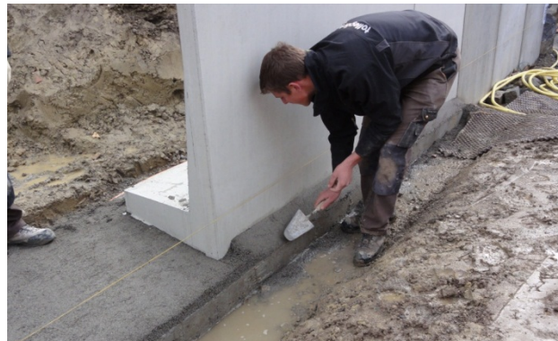
Bild 37: Erstellen der Fundamentnocken
