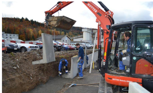
Bild 35: Versetzen der Winkelplatten
