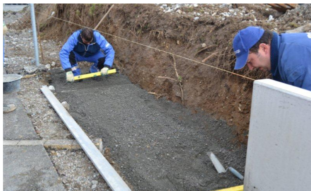
Bild 33: Erstellen des Streifenfundamentes
