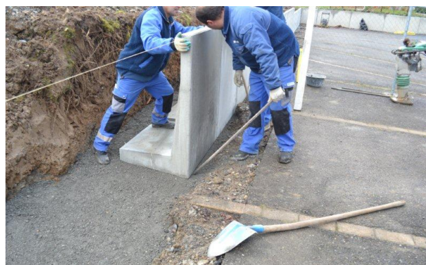
Bild 36: Richten der Winkelplatte
