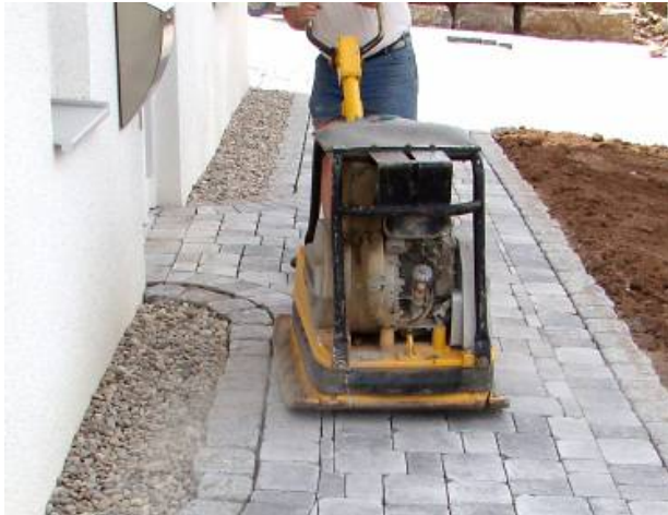
Bild 36: Abrütteln der Pflasterfläche
