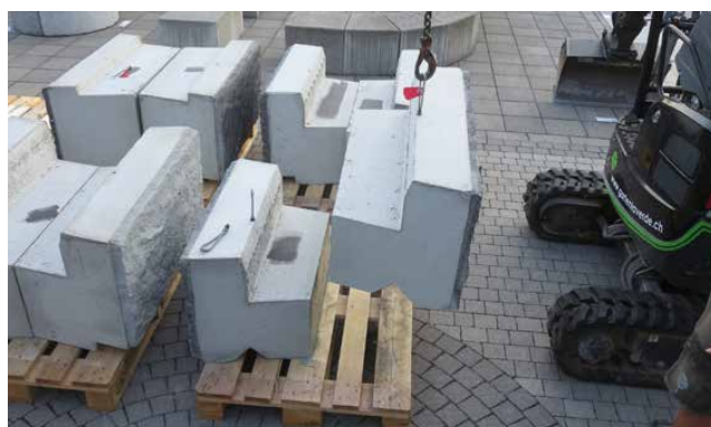
Illustration 21 : douilles de transport M16 montées en usine
