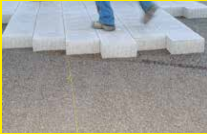
Einschnürung der Verlegeeinheit
